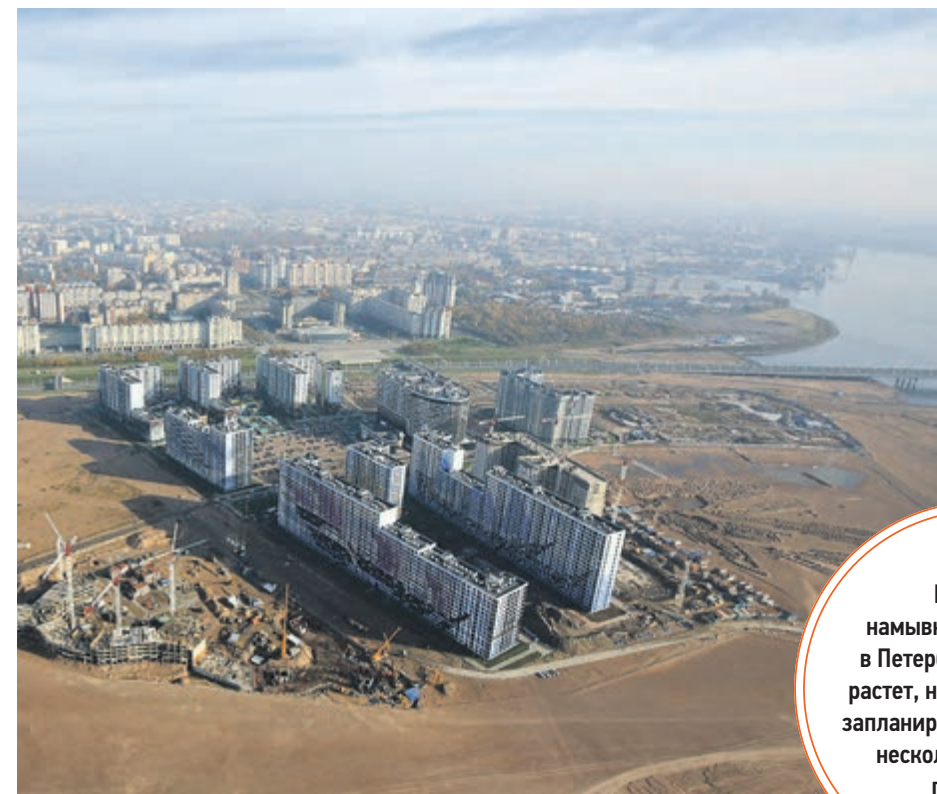
ФОТО: ИНТЕРПРЕСС / Г. ПОЛЯКОВ
